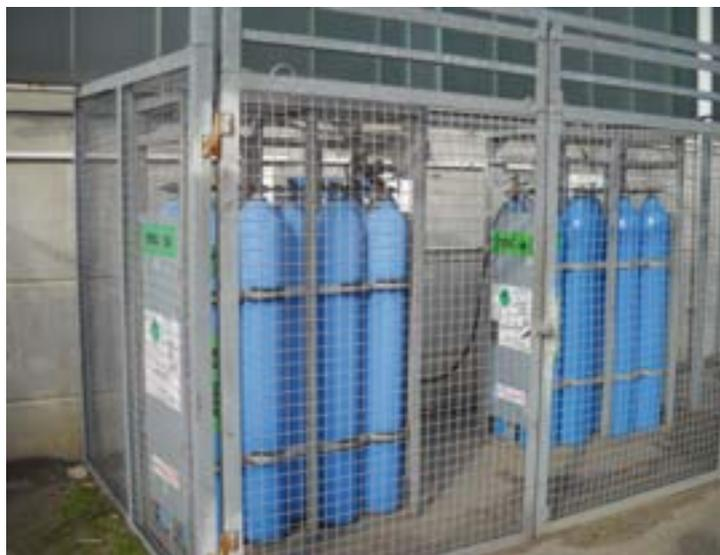
FIGURE 169 : CENTRALE DE BOUTEILLES DE GAZ
