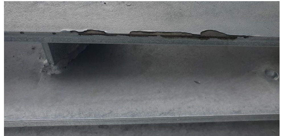
Galvanisation sans rayonnage des arêtes
