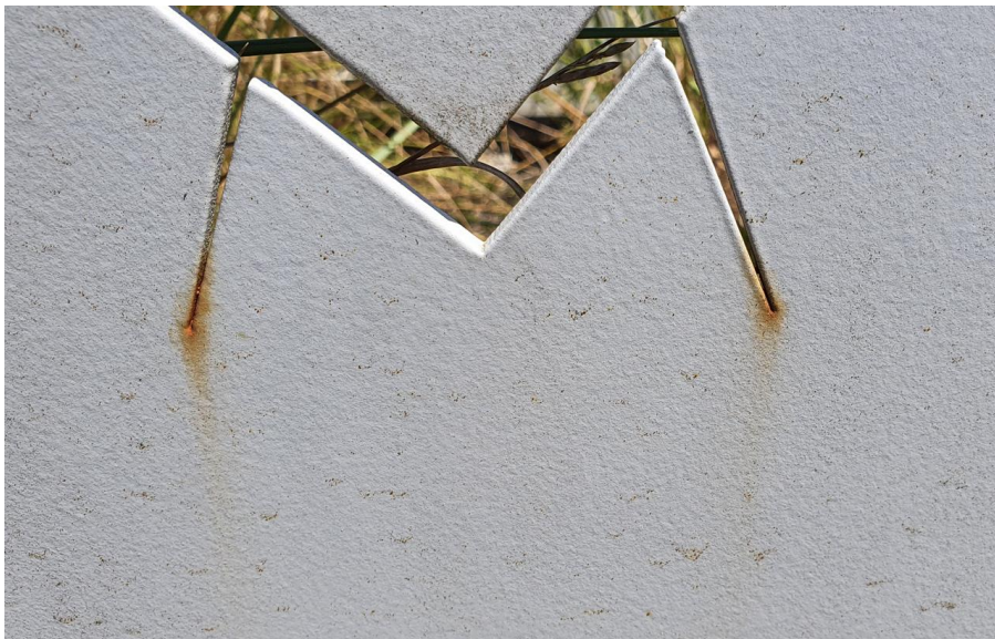
Tôle perfo bouchée par le Zinc
